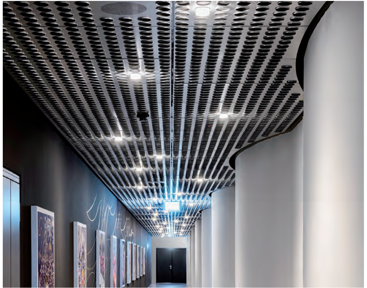
Ein solches Projekt macht Sven stolz: Die Verbauung der speziellen Kühldecken in der Swiss Life Arena.
