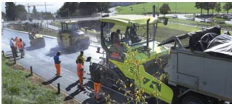
Belageinbau an der Alten Forchstrasse.
