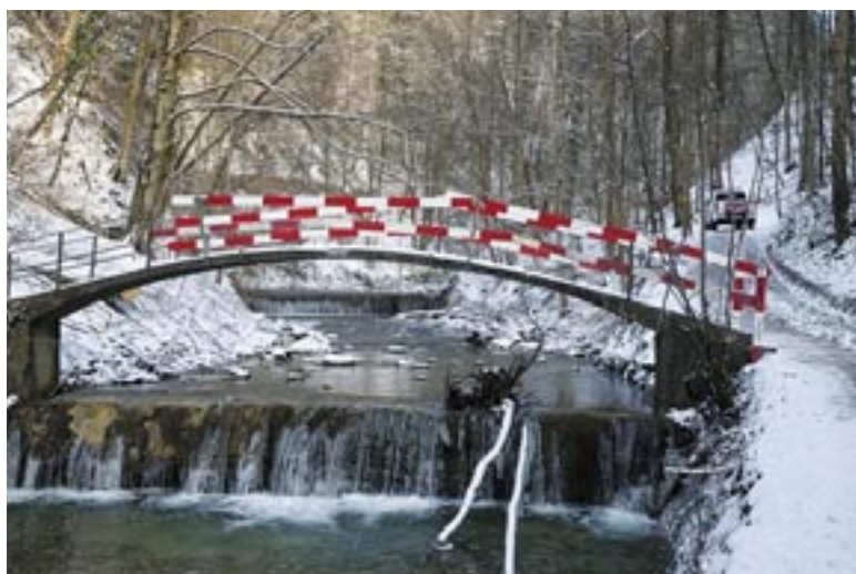
Momentan ist die Brücke normal begehbar und die Absperrlatten ersetzen temporär das Geländer.
