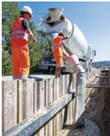
Einbau von Flüssigboden an der Alten Forchstrasse.
