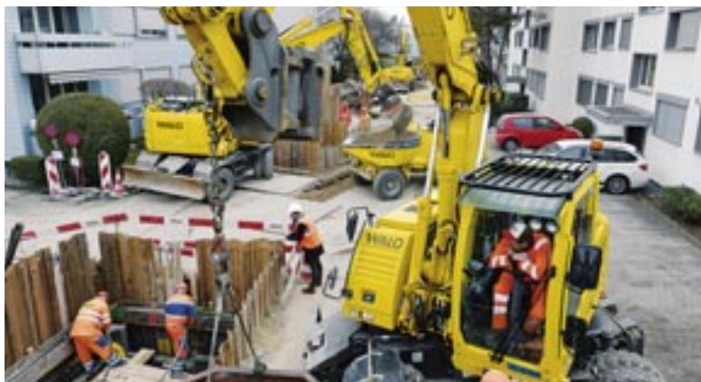
Beschleunigte Bauweise an der Eigenheimstrasse.
