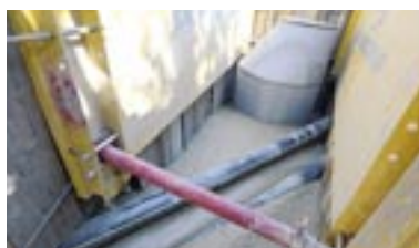
Eingebauter Flüssigboden bei Leitungsquerungen.
